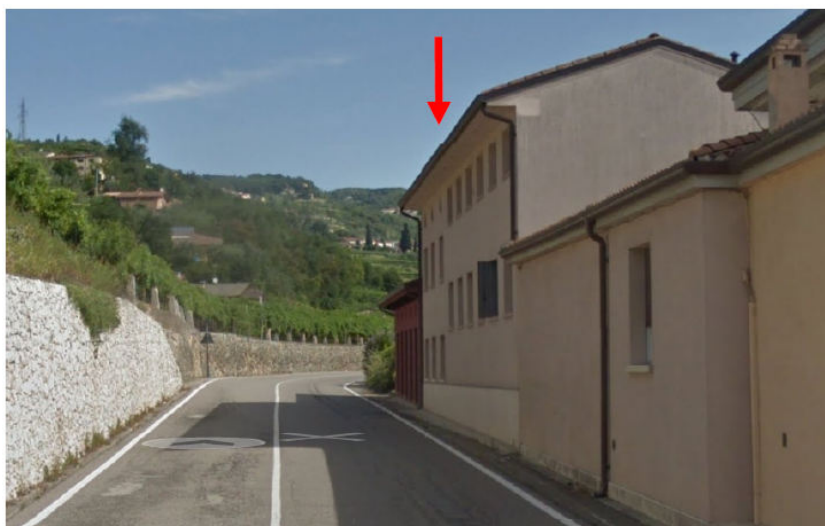
vista lungo strada da sud
