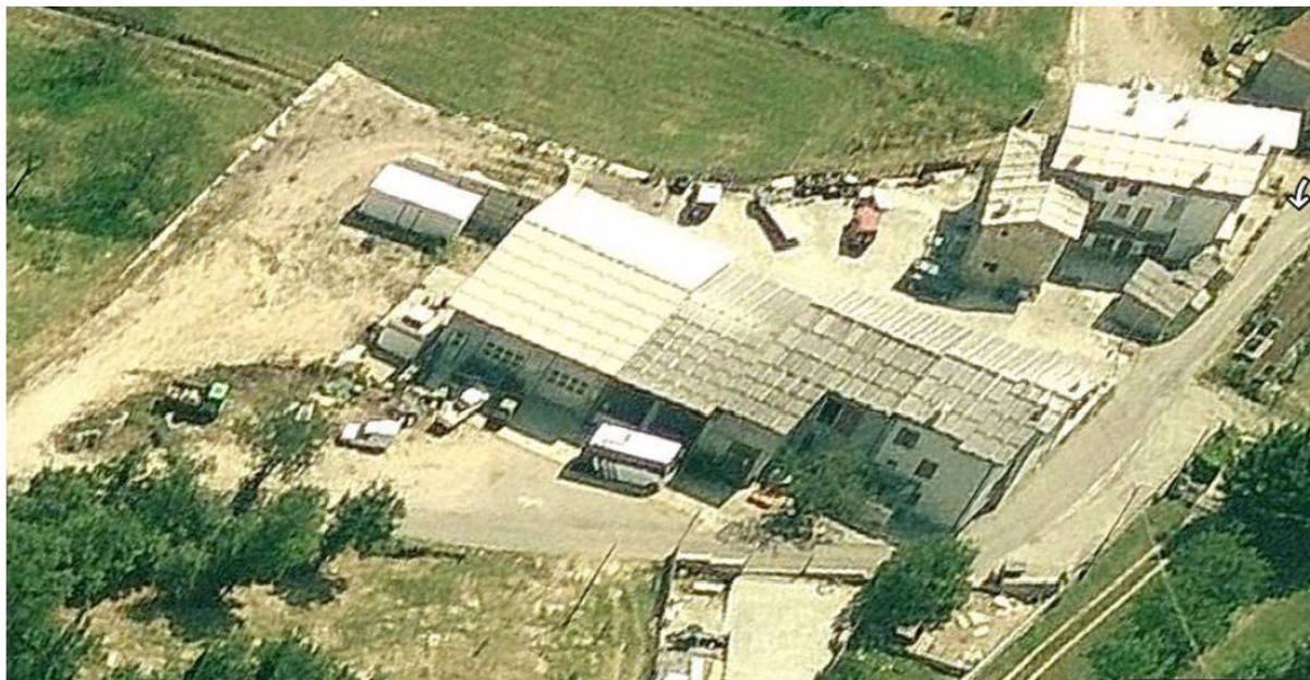
vista da ovest
